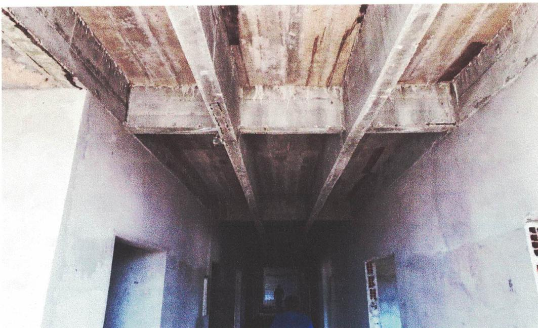
**Fotografia 2 – Vigas executadas com desconformidades do projeto**
