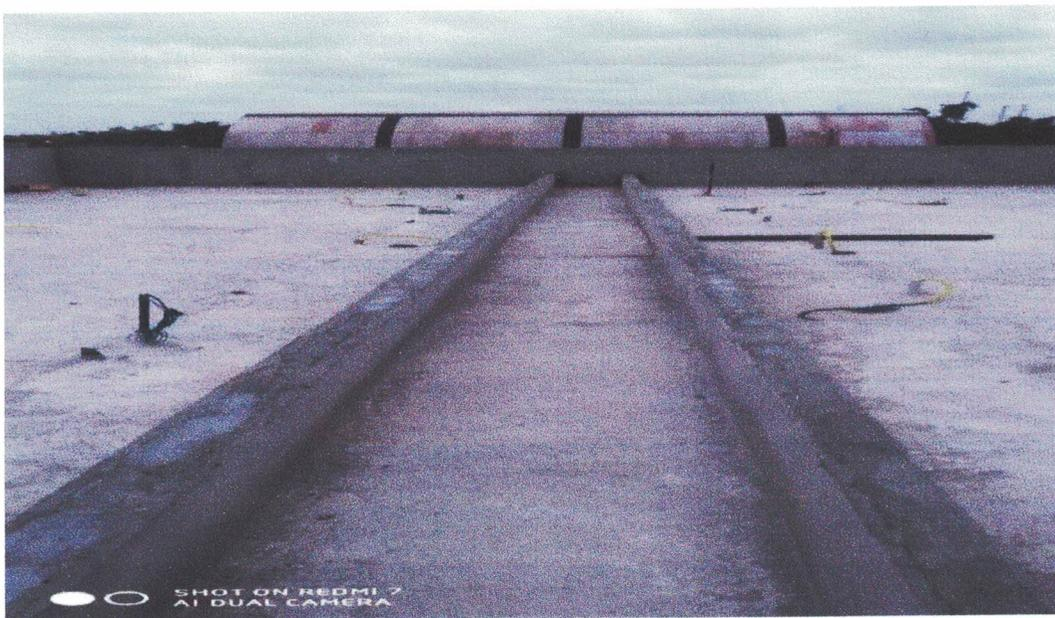
**Fotografia 1 – Calha (Viga Invertida) executada corretamente conforme o projeto aprovado**
