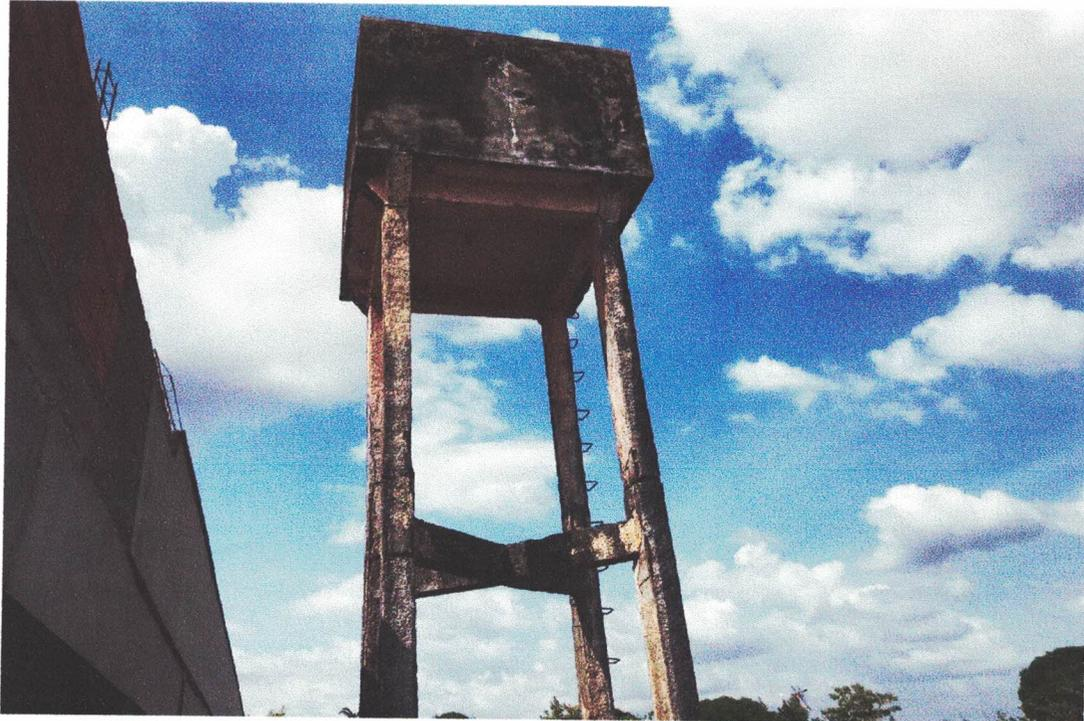
**Fotografia 5 – Caixa d'água com sinais de desabamento, ao lado do bloco**
