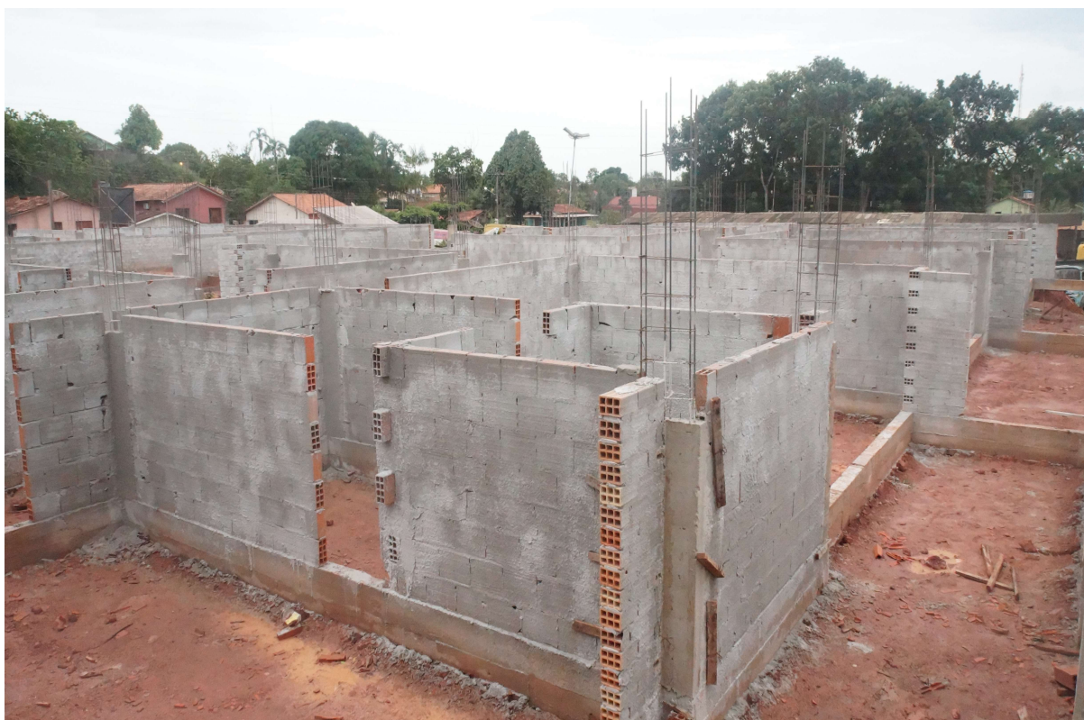
Foto da Alvenaria construída da Creche.
