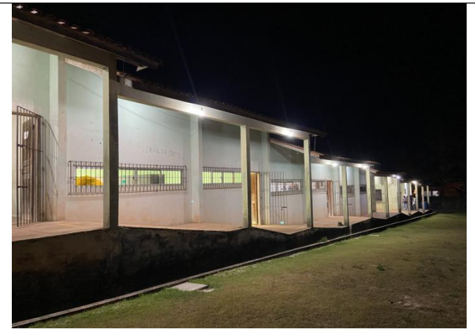
Figura 4 - Desnível Existente da Escola
