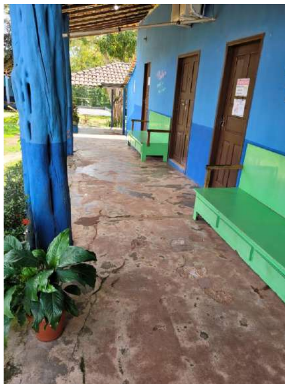
FOTOGRAFIA 19 - ÁREA DE REFORMA
