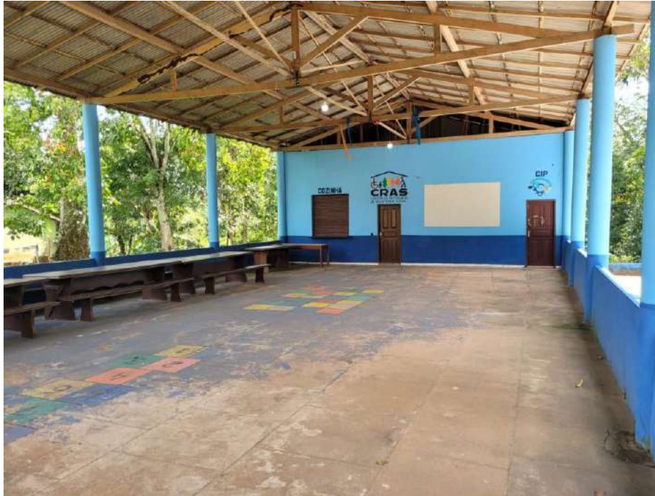
FOTOGRAFIA 8 - ESPAÇO RECREATIVO A REFORMAR
