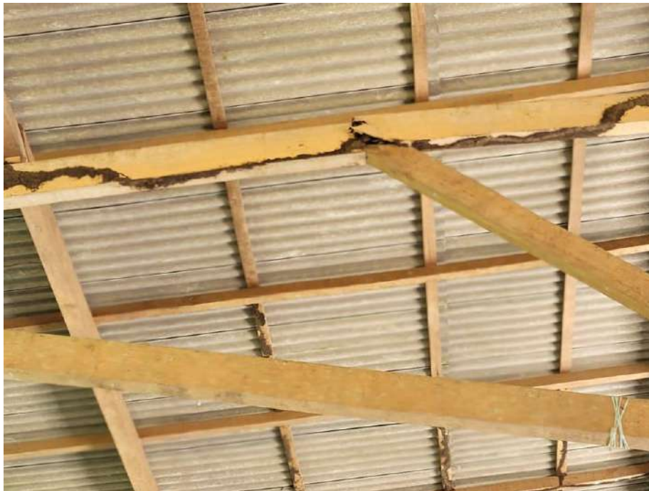
FOTOGRAFIA 13 - ESTRUTURA DE MADEIRA DA COBERTURA A RECUPERAR
