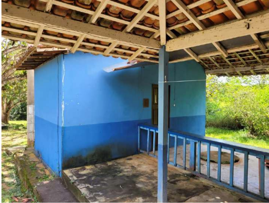
FOTOGRAFIA 10 - ÁREA A REFORMAR
