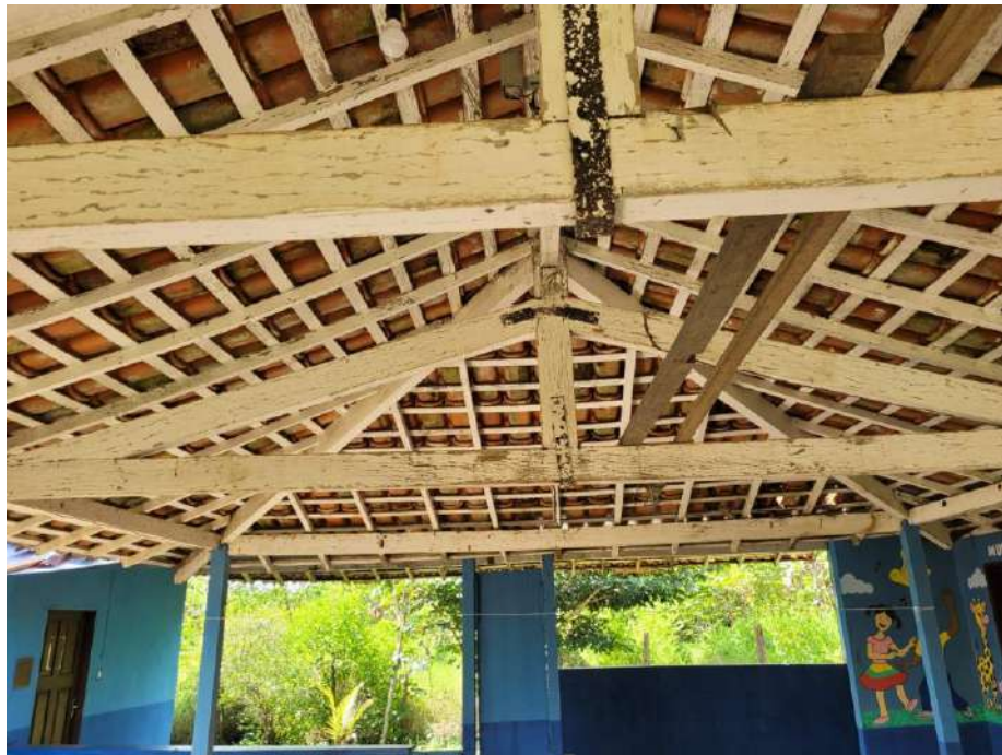
FOTOGRAFIA 11 - ESTRUTURA DE MADEIRA DA COBERTURA A RECUPERAR
