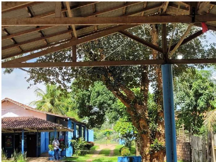
FOTOGRAFIA 9 - ESTRUTURA DE MADEIRA DA COBERTURA A RECUPERAR
