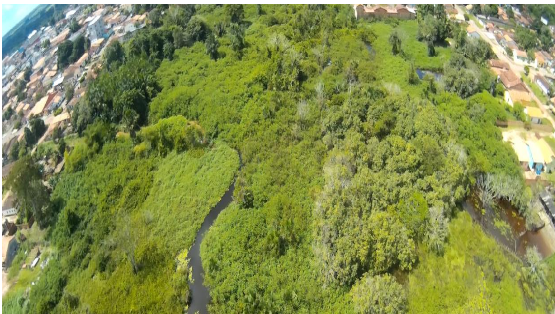
Figura 22 - Local a sofrer intervenção.
